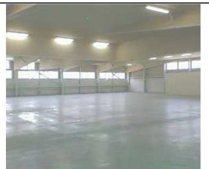
2階・倉庫・作業所
