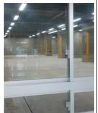
事務所から見た倉庫
